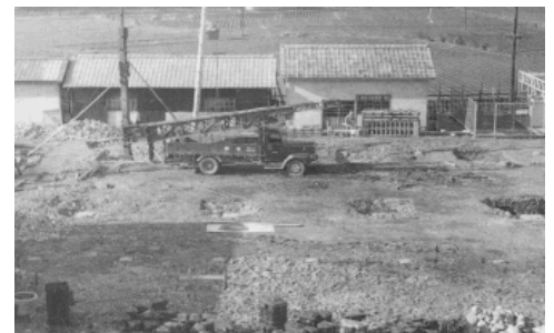
<工場建設風景>
