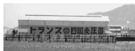
<大型工場完成>
