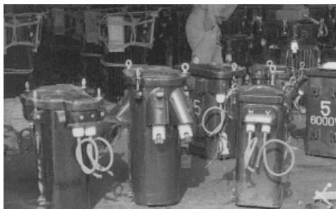
<焼損変圧器の修理>
