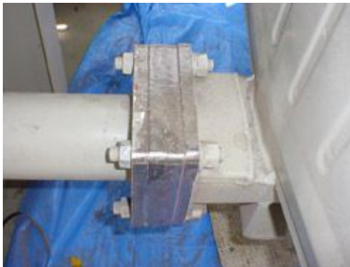
(1) 清掃及びケレン完了後
