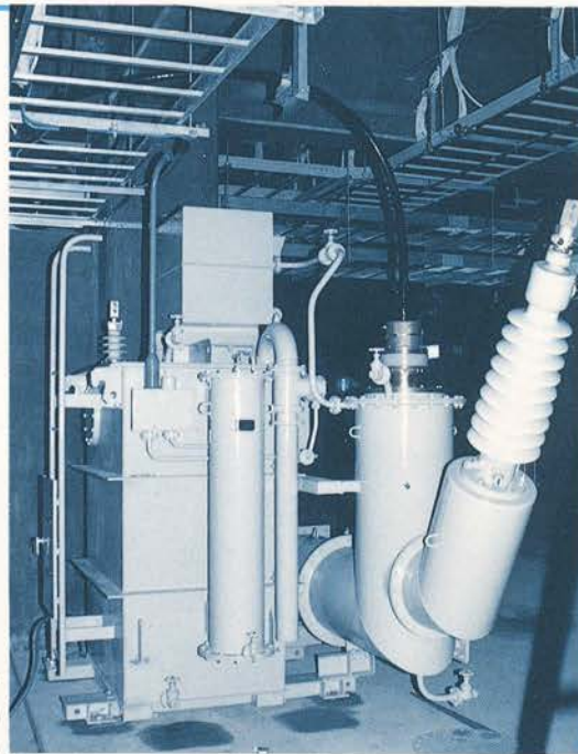
中性点接地リアクトル (Neutral Grounding Reactor) 66kV 10MVA
