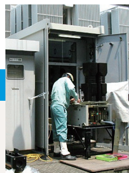
配電盤の修理
