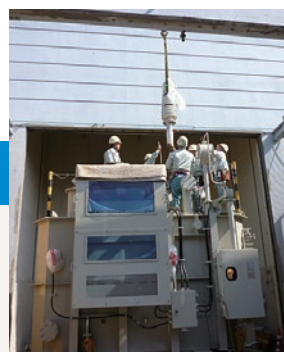
変圧器の設置
