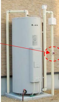
温水器専用止水栓：バルブ
