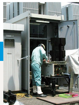
配電盤の修理
