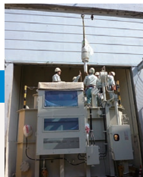
変圧器の設置
