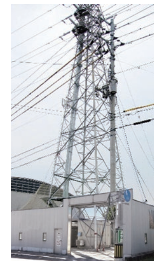
66kV 送電線鉄塔
