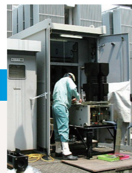
配電盤の修理
