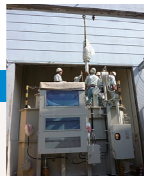
変圧器の設置
