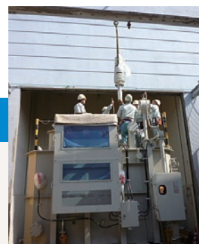
変圧器の設置
