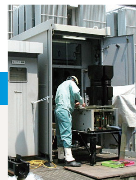
配電盤の修理
